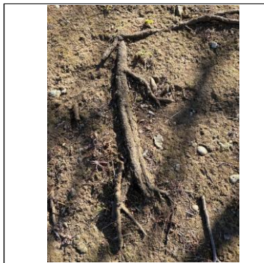
【写真-2】露出根 樹皮欠損
